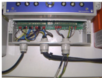
Die Bedrahtung ist jetzt sichtbar LINKS; PUMPEN RECHTS; ELEKTRODEN
